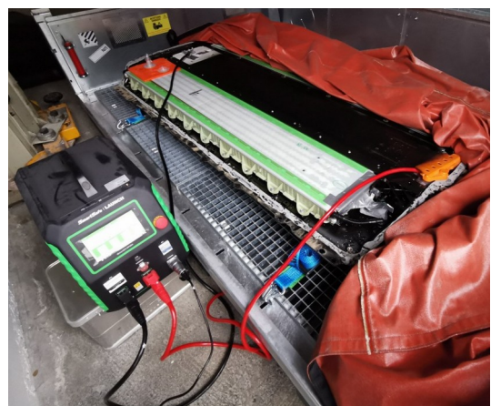
Das Entladen der Tesla-Batterie erfolgt in einem Spezialkonainer
